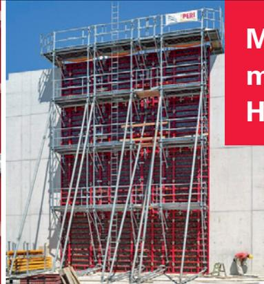
**MAXIMO. Die Rahmenschalung mit der MX Ankertechnik ohne Hüllrohre und Konen**
