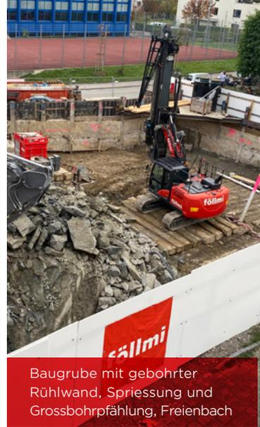
Baugrube mit gebohrter Rühlwand, Spriessung und Grossbohrpfählung, Freienbach
