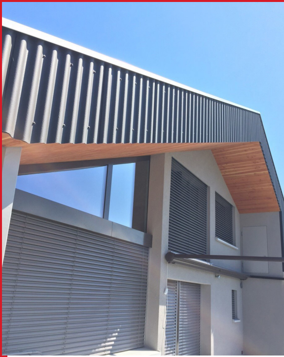
Eternit Ondapress-36, Untersicht Douglasie farblos lasiert, Dachsanierung EFH, Laufen
