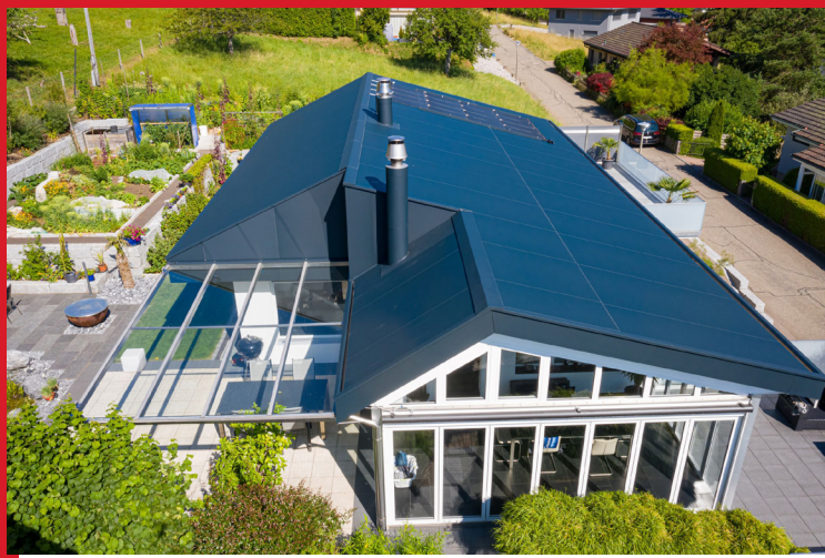
Prefa Verbundplatten anthrazit, modulare Ausführung – Dachsanierung EFH, Nunningen
