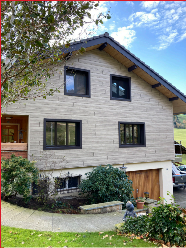
Prefa Siding mit Schattenfuge Eiche grau – Fassaden- und Dachsanierung, Beinwil
