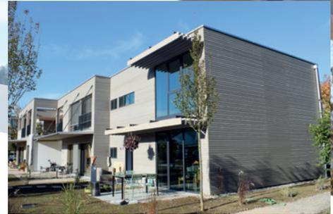
Die Elemente werden von uns am Computer mit SEMA/CAD-Programmen geplant und in unserer Abundhalle vorgefertigt. Die Konstruktion übernimmt mit der Lukas Kalt AG in Leibstadt ein langjähriger und erfahrener Partner. Die Zusammensetzung des fertigen Gebäudeteils mit Dämmungen und Vorinstallationen für die Gebäudetechnik wird danach durch unser Team durchgeführt.
